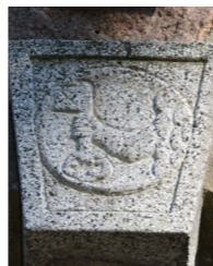
Schlussstein über dem Eingangsportal der St.-Petri-Kirche
